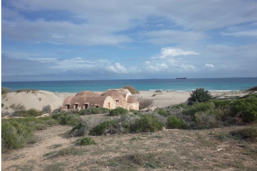
شكل رقم (16) توضح زحف الكثبان الرملية علي مبني حمامات الصيد من تصوير الباحث
