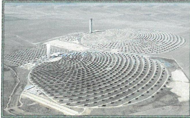
صورة (7): نموذج لمحطات المركبات الشمسية باستخدام تقنية الأبراج
