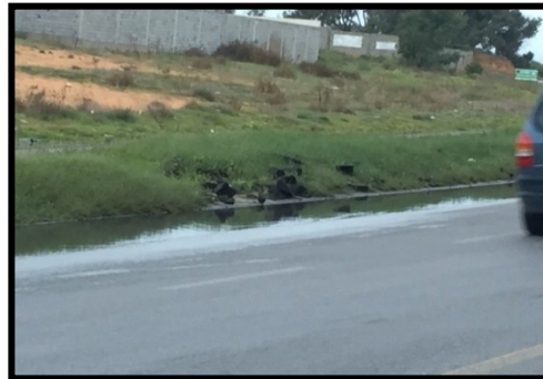
شكل رقم (3): يوضح عوائق في الفاصل الوسطى والحواجز المرورية المتهاكة مع تجمع المياه والمخلفات بجانب البردورة
