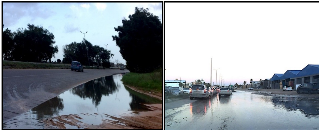
شكل رقم (5): يوضح الميول الجانبية الغير جيدة ووجود مياه الأمطار
