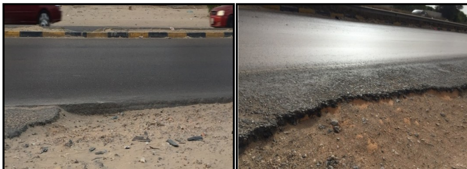
شكل رقم (2): يوضح أضرار بحافة الرصف مع وجود حفر داخل الأكتاف
