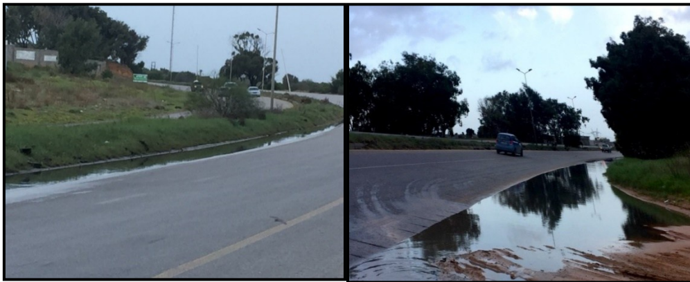
شكل رقم (7): يوضح تجمع مياه الأمطار بجانب البردورات وبجانب الطريق
