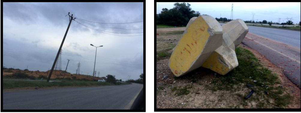
شكل رقم (6): يوضح العوائق القريبة من الطريق التي تتطلب تركيب قضبان حماية أو الإزالة
